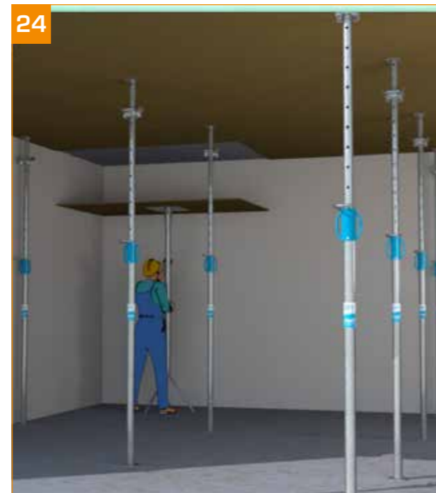
24 - Utiliser un lève-plaque pour retirer le CP.
