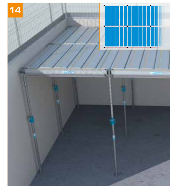
14 - Continuer l'avancement des panneaux Éco+ à l'aide de la TopPerche Éco, de proche en proche.
