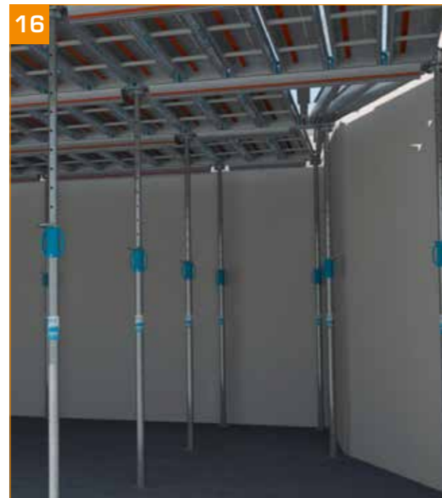
16 - Affiner la mise à niveau à l'aide d'un niveau laser ST par ST. - Une pige suspendue au coffrage permet à un seul homme d'effectuer le réglage avec le niveau laser. - Effectuer un dernier contrôle du verrouillage des têtes à cette étape.
