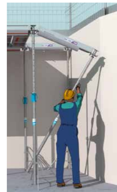
Les poutrelles extensibles permettent de se rapprocher des bords de la cellule
