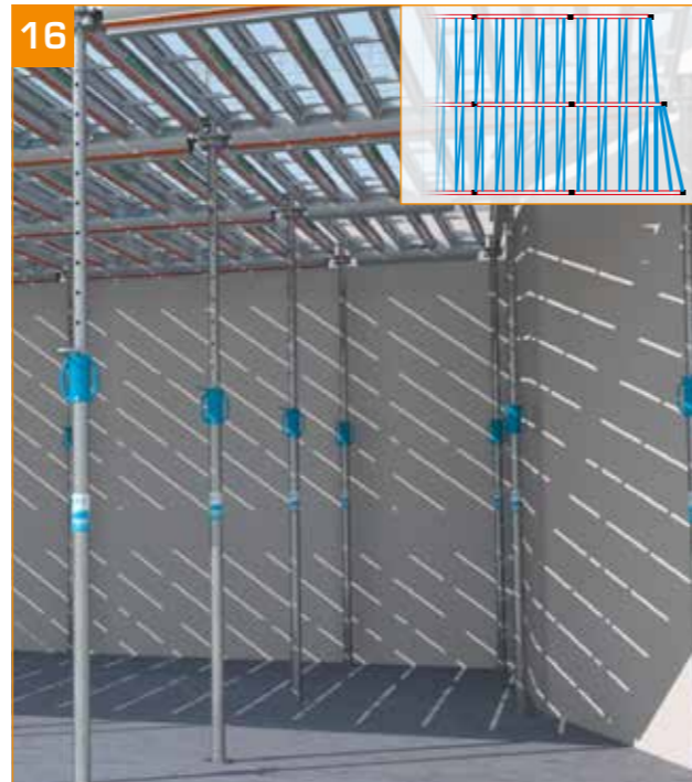
- Affiner la mise à niveau à l'aide d'un niveau laser ST par ST. - Une pige suspendue au coffrage permet à 1 seul homme d'effectuer le réglage avec le niveau laser. - Effectuer un dernier contrôle du verrouillage des têtes à cette étape.
