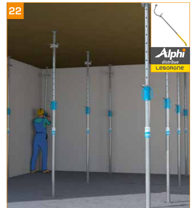
- Décoffrage de la dalle : enlever les ST placés en périphérie des cellules. - Laisser en place pendant 3 jours minimum les autres ST (selon type de béton et température extérieure).
