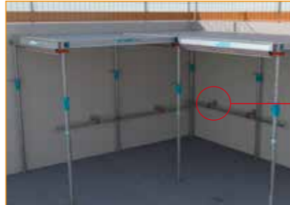
- Mettre en place la stabilisation des premiers éléments. Une fois la stabilisation en place il est possible de retirer les trépieds.
