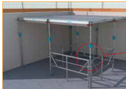
- Positionner les 4 étais comme souhaité puis fixer le cadre étais.
