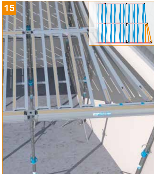
- Renouveler l'étape 6 et terminer la mise en place des cadres secondaires C2+ ou C4+.
