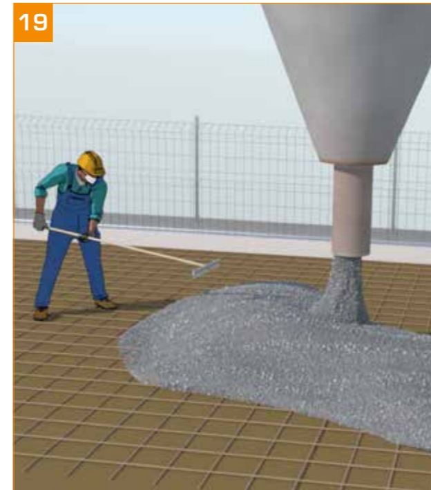
- Réalisation de la dalle béton après ferrailage et incorporations. → Répartition du béton sur le coffrage sans surcharge des poutrelles et ST.
